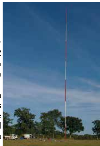
Exemple de mât de mesure
